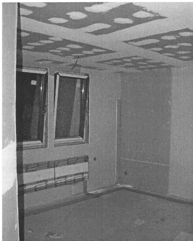
Dostavba ubytovny finišuje
