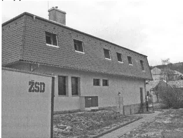
Kolaudace přístavby nad kotelnou proběhla 20. března
