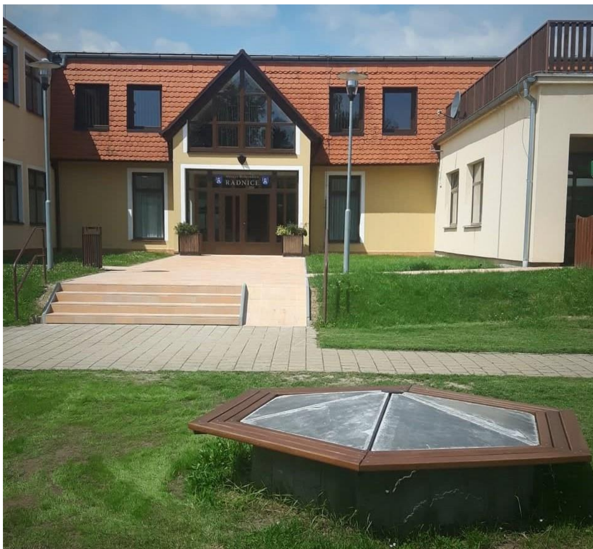
Opravená dlažba a schody před radnicí, nová „studňolavice“
