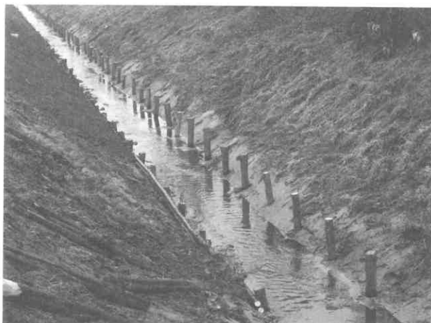
Z opravy potoka Haraska
